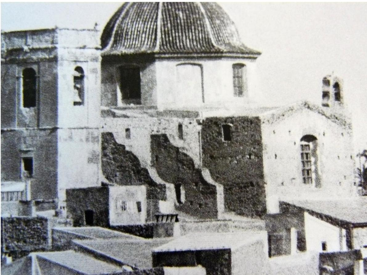
En las imágenes del 1930 nos demuestran el mal estado del edificio antes de ser incendiado el 20 de febrero de 1936 después del incendio quedo destrozada toda la decoración y afectadas las paredes del interior sobre todo el revestimiento de yeso ya que es muy frágil al fuego teniendo en cuenta que PEDRO IBARRA en su libro de 1895 nos indica que ya empezaban las grietas.
