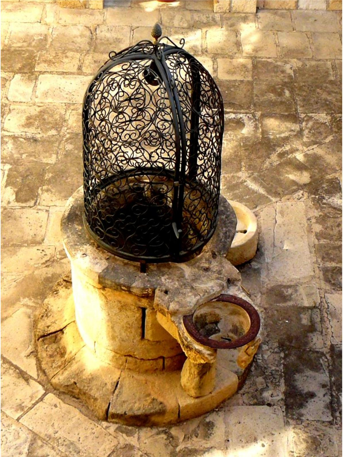
IMAGEN DEL POZO EN ESTADO DE DETERIODO DEVIDO AL DESGASTE DE LA PIEDRA
